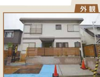
古くなった外壁をガルバリウム鋼板のカバー工法と再塗装でイメージ刷新。断熱材を入れて断熱効果もUP。
